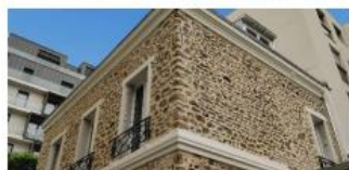
Joints entre pierres à la chaux
